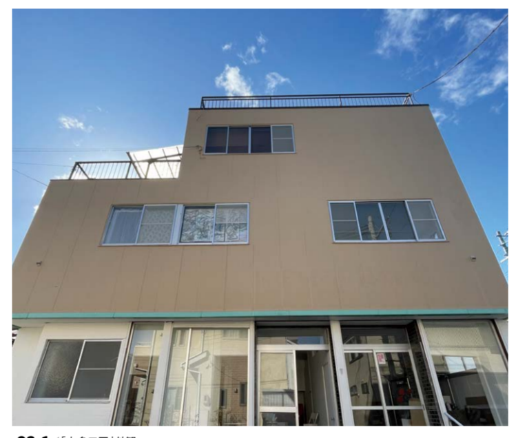
02-1 / 「本多工房」外観
